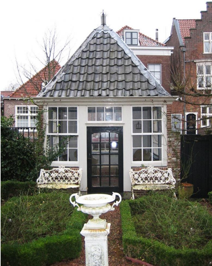
DE ENTREE VAN DE KOEPEL VANUIT DE TUIN VAN MUURHUIZEN 177
