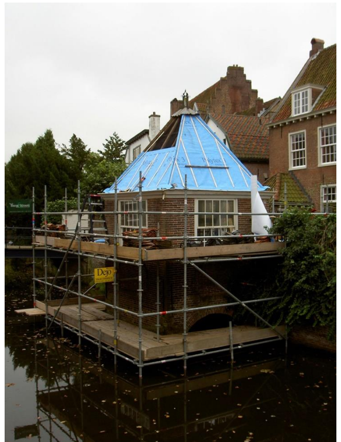
RENOVATIE VAN HET DAK, ENKELE JAREN GELEDEN
